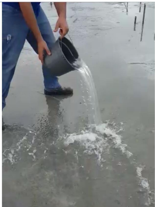
Figura 9 - Lançamento de água sobre a laje.
