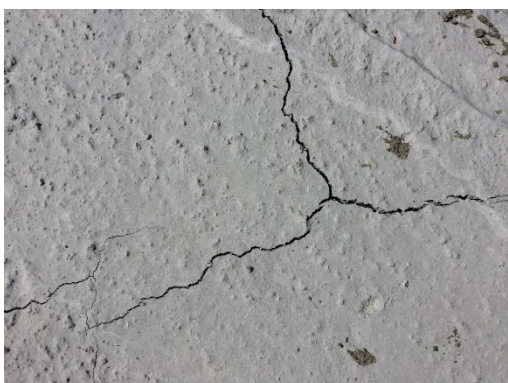
Figura 2 – Aparência superficial das fissuras (a) e abertura real (b).
