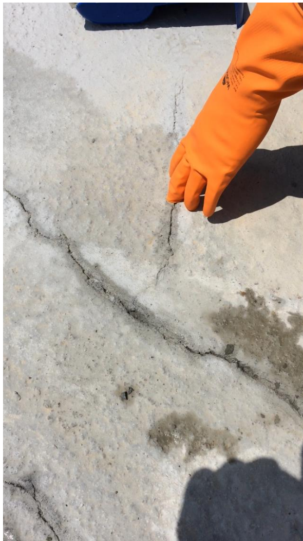
Figura 5 – Umedecimento da área a ser tratada.
