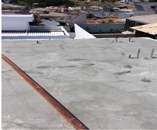
Figura 8 – Aplicação da calda com vassoura (a) e aparência final do tratamento (b).
