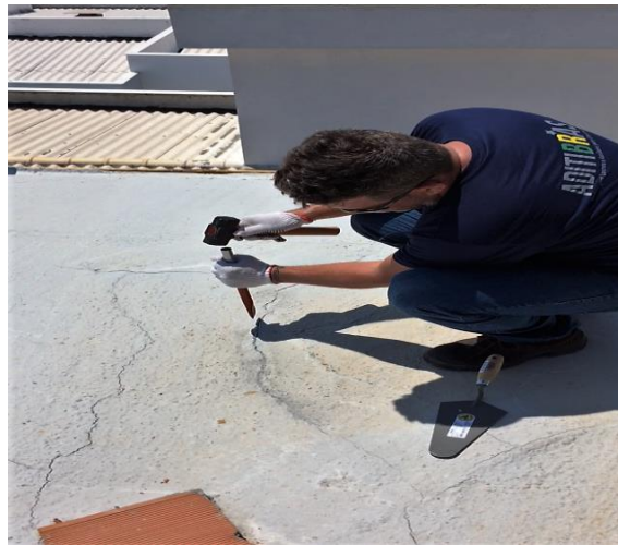
Figura 3 – Apicoamento das fissuras.
