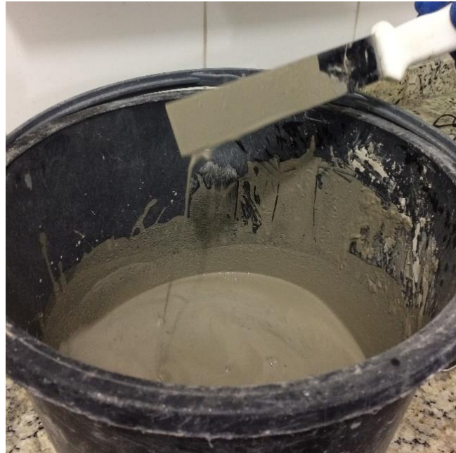
Figura 6 – Preparo da calda com a adição de ADI-CRIL S28 (a) e consistência final da calda (b).
