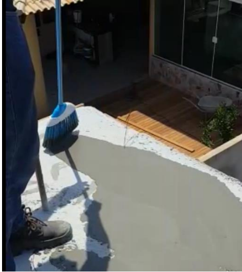
Figura 8 – Aplicação da calda com vassoura (a) e aparência final do tratamento (b).
