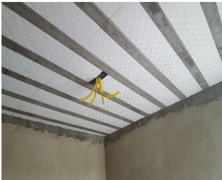
Figura 11 – Interior da casa apresentando nenhum tipo de vazamento.
